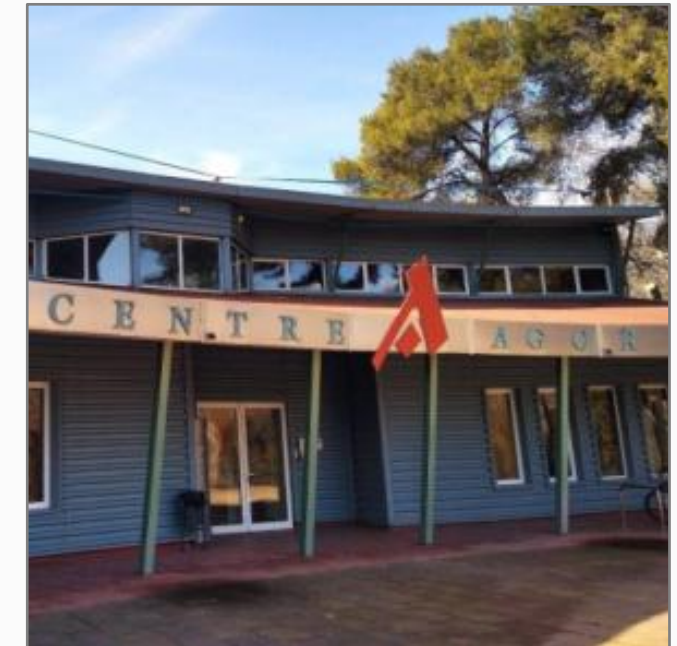
Millores funcionals i energètiques en el Centre Àgora
